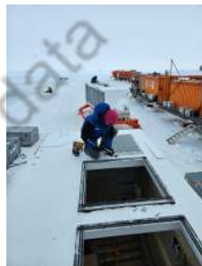
préparation de la surface avec du mastic silicone
